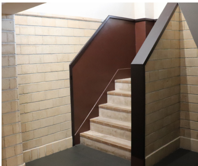
写真4：テラスへ上がる階段の壁面のタイル 創建当時の状態で残されている。
