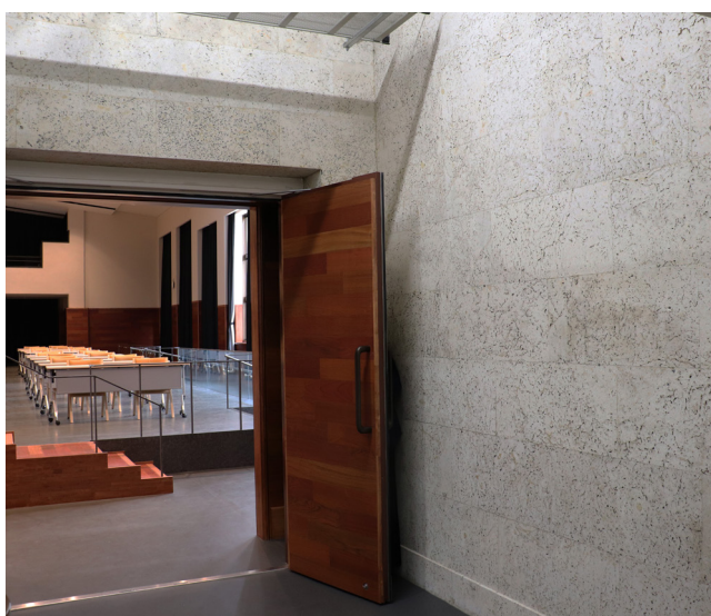
写真5：石灰岩の石材が用いられている入り口控え室の壁面
