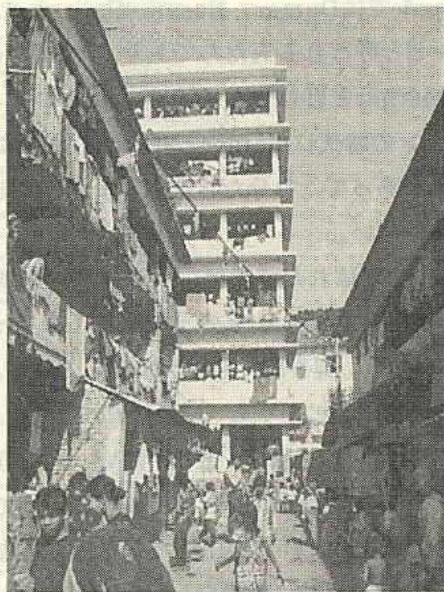
写真① BSCの5、6階が増築された住宅棟(正面)
