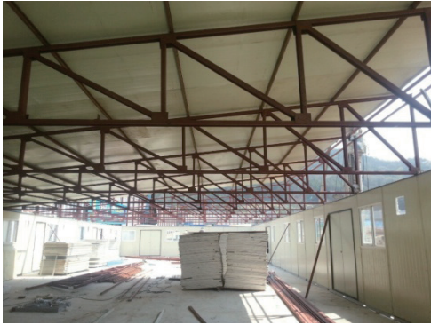
仮設建物飯場の工事
