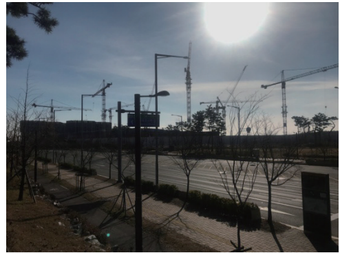
飯場近所の建設現場
