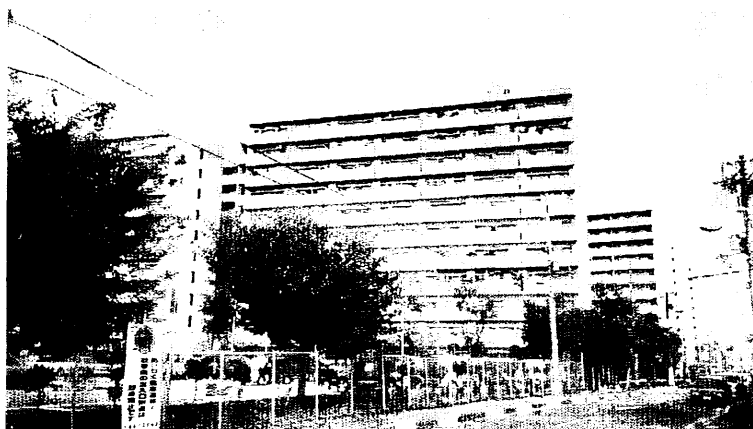
写真3 泉尾第4 住宅 (クブングワー住民たちが入居した改良住宅)
